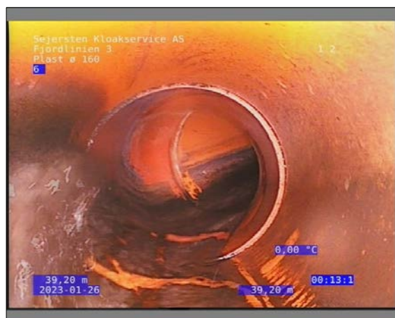
Foto: 24_1_17_26012023_102715_1.JPG 39,26m, Konstruktionsændring klasse 0, Retningsændringer urref 02 / 45 grader - skønnet
