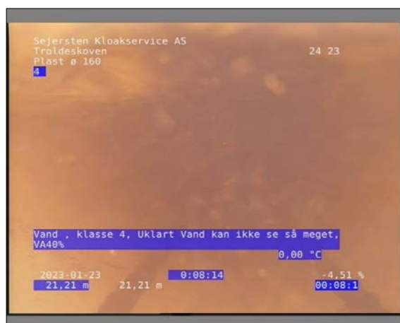
Foto: 8_1_15_23012023_132848_1.JPG 21,2m, Vand , klasse 4 / Uklart Vand kan ikke se så meget, VA40%
