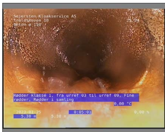
Foto: 21_1_10_25012023_133507_1.JPG 5,38m, Rødder klasse 1, fra urref 03 til urref 09, Fine rødder / Rødder i samling
