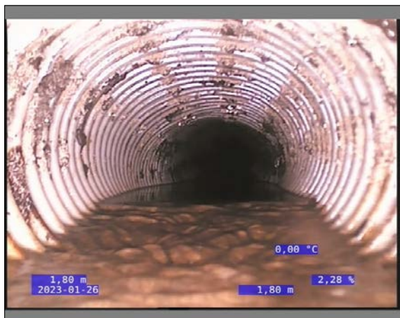
Foto: 23_1_10_26012023_094339_1.JPG 1,8m, Aflejring klasse 3, fra urref 00 til urref 12, Sand/Grus, Start
