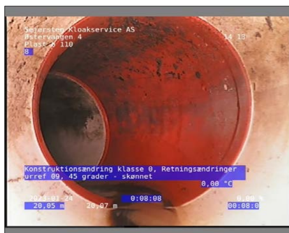
Foto: 14_1_17_24012023_114552_1.JPG 20,07m, Konstruktionsændring klasse 0, Retningsændringer urref 09 / 45 grader - skønnet
