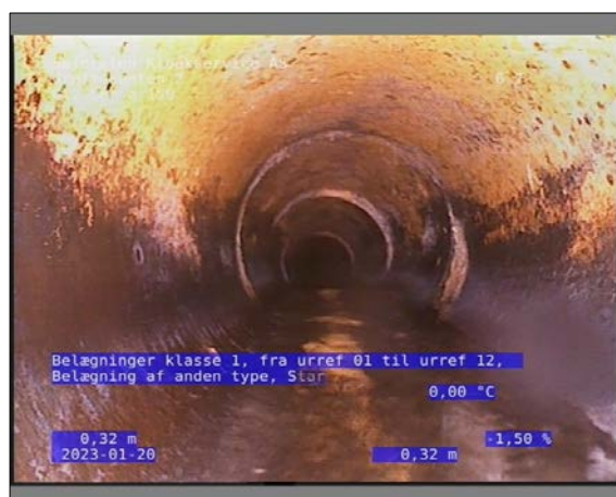
Foto: 4_1_4_20012023_102128_1.JPG 0,32m, Belægninger klasse 1, fra urref 01 til urref 12, Belægning af anden type, Start
