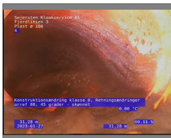
Foto: 25_1_17_27012023_085908_1.JPG 31,28m, Konstruktionsændring klasse 0, Retningsændringer urref 08 / 45 grader - skønnet
