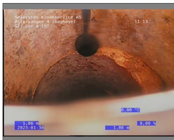
Foto: 30_1_11_30012023_125920_1.JPG 1,86m, FS3, Forskudt samling
