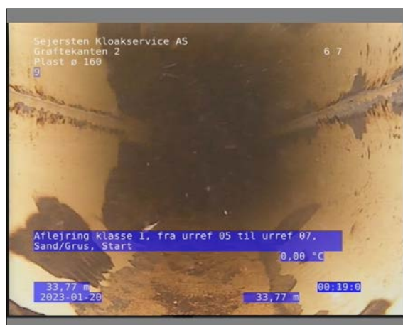
Foto: 4_1_33_20012023_104809_1.JPG 33,77m, Aflejrning klasse 1, fra urref 05 til urref 07, Sand/Grus, Start
