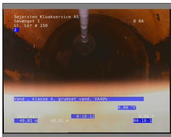
Foto: 28_1_42_27012023_105301_1.JPG 40,02m, Vand , klasse 4 / grumset vand, VA40%
