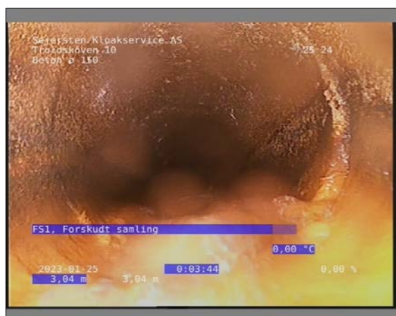
Foto: 21_1_8_25012023_133314_1.JPG 3,04m, FS1, Forskudt samling
