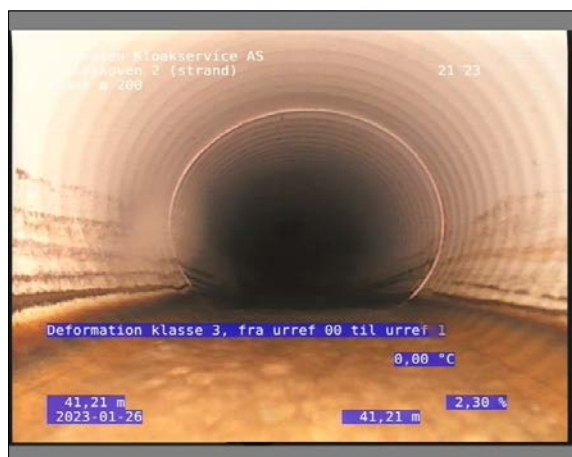
Foto: 22_1_22_26012023_082512_1.JPG 41,21m, Deformation klasse 3, fra urref 00 til urref 12, Vertikal deformation
