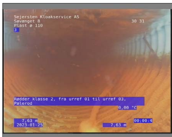
Foto: 17_1_13_25012023_090853_1.JPG 7,63m, Rødder klasse 2, fra urref 01 til urref 03, Pælerod
