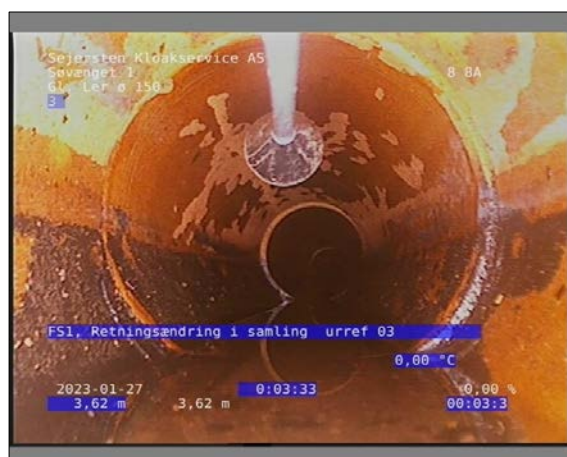
Foto: 28_1_9_27012023_102911_1.JPG 3,63m, FS1, Retningsændring i samling urref 03
