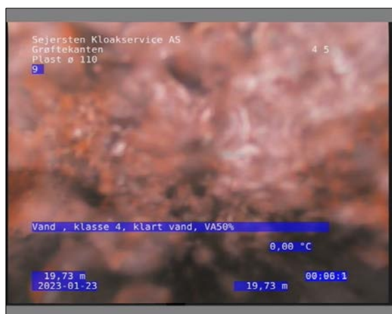
Foto: 6_1_8_23012023_102716_1.JPG 19,73m, Vand , klasse 4 / klart vand, VA50%
