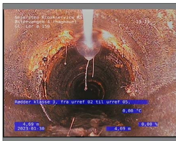
Foto: 31_1_21_30012023_142537_1.JPG 4,69m, Rødder klasse 3, fra urref 02 til urref 05, Rodklump, Stop
