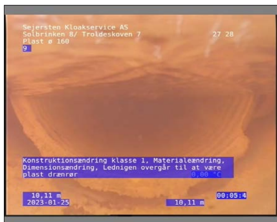
Foto: 20_1_11_25012023_124020_1.JPG 10,11m, Konstruktionsændring klasse 1, Materialeændring, Dimensionsændring / Lednigen overgår til at være plast drænrør
