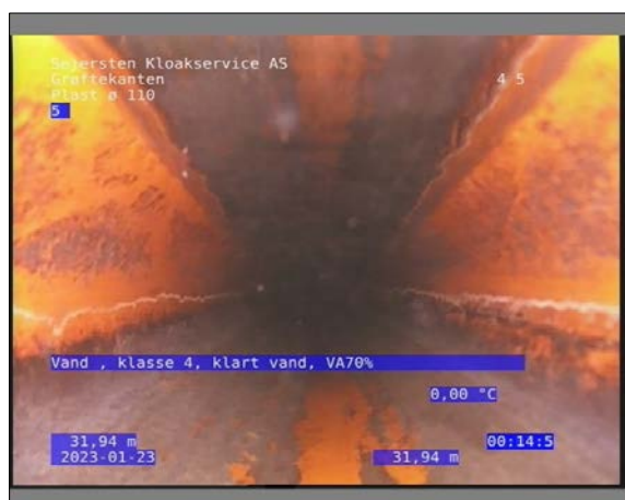
Foto: 6_1_13_23012023_103743_1.JPG 31,94m, Vand , klasse 4 / klart vand, VA70%
