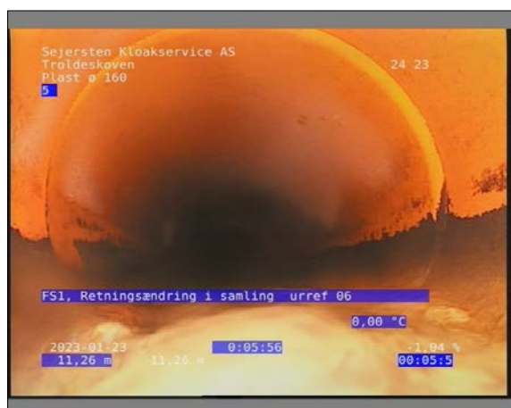
Foto: 8_1_11_23012023_132522_1.JPG 11,26m, FS1, Retningsændring i samling urref 06
