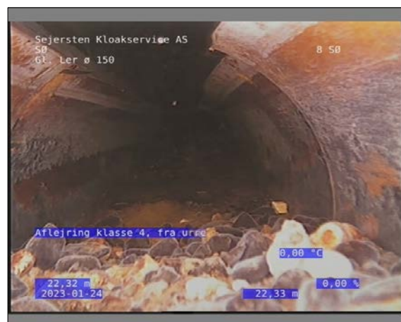
Foto: 16_1_18_24012023_142057_1.JPG 22,33m, Aflejring klasse 4, fra urref 00 til urref 12, Sand/Grus, Start / 80% - skønnet
