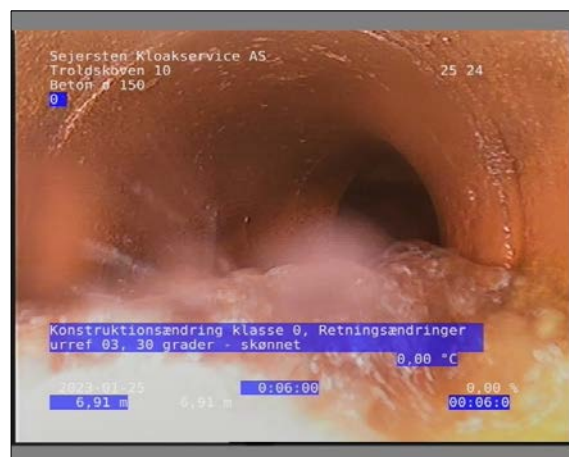
Foto: 21_1_11_25012023_133650_1.JPG 6,91m, Konstruktionsændring klasse 0, Retningsændringer urref 03 / 30 grader - skønnet
