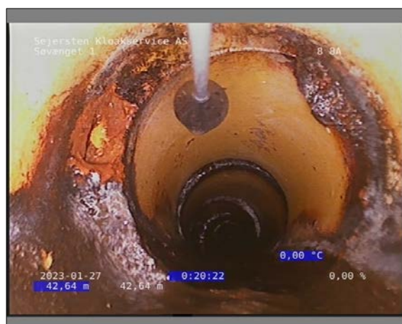
Foto: 28_1_46_27012023_105555_1.JPG 42,64m, FS3, Forskudt samling
