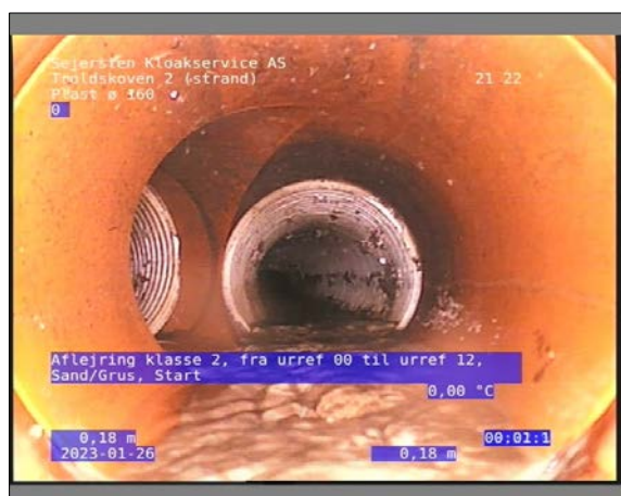
Foto: 23_1_4_26012023_093727_1.JPG 0,18m, Aflejring klasse 2, fra urref 00 til urref 12, Sand/Grus, Start
