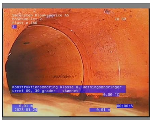
Foto: 11_1_4_24012023_080006_1.JPG 0,01m, Konstruktionsændring klasse 0, Retningsændringer urref 09 / 30 grader - skønnet
