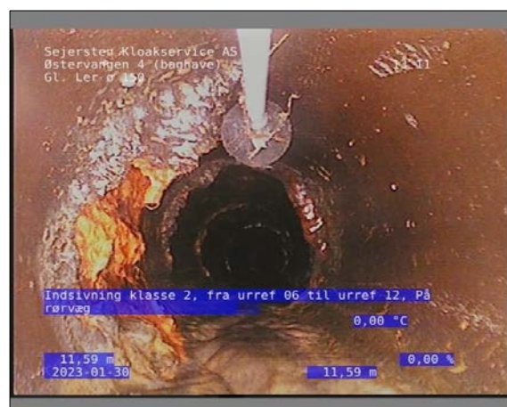
Foto: 31_1_33_30012023_143402_1.JPG 11,59m, Indsivning klasse 2, fra urref 06 til urref 12, På rørvæg
