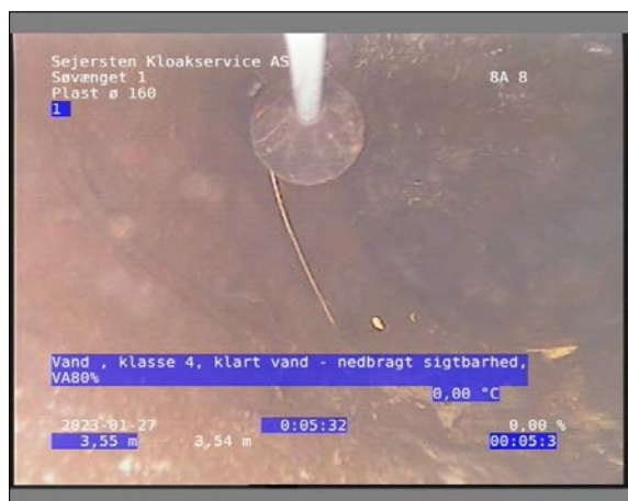
Foto: 29_1_12_27012023_113748_1.JPG 3,54m, Vand, klasse 4 / klart vand - nedbragt sigtbarhed, VA80%
