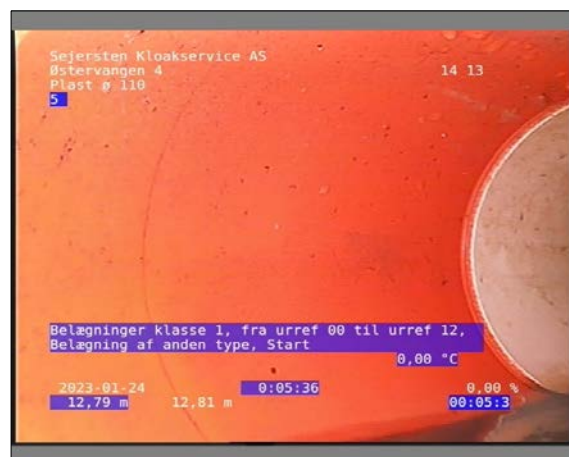
Foto: 14_1_12_24012023_114143_1.JPG 12,81m, Belægninger klasse 1, fra urref 00 til urref 12, Belægning af anden type, Start
