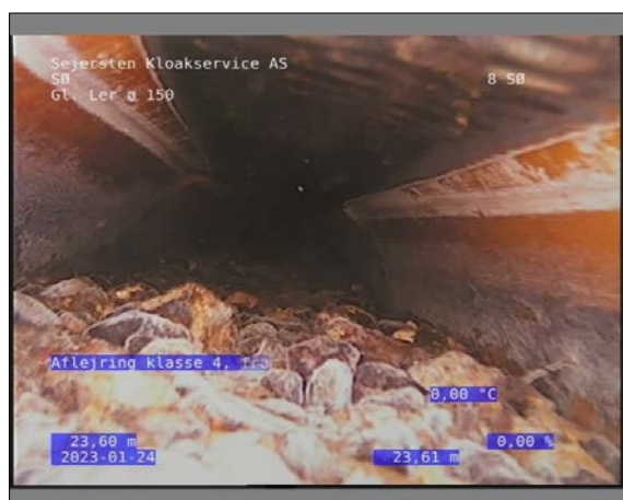
Foto: 16_1_19_24012023_142226_1.JPG 23,61m, Aflejring klasse 4, fra urref 00 til urref 12, Sand/Grus, Stop
