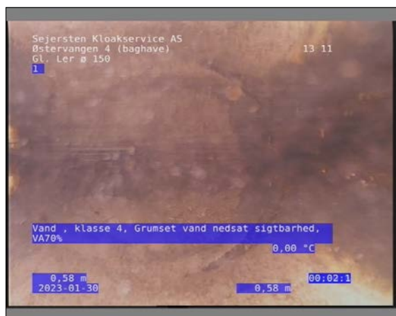
Foto: 31_1_6_30012023_140231_1.JPG 0,59m, Vand , klasse 4 / Grumset vand nedsat sigtbarhed, VA70%
