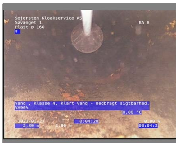
Foto: 29_1_11_27012023_113605_1.JPG 2,8m, Vand , klasse 4 / klart vand - nedbragt sigtbarhed, VA90%
