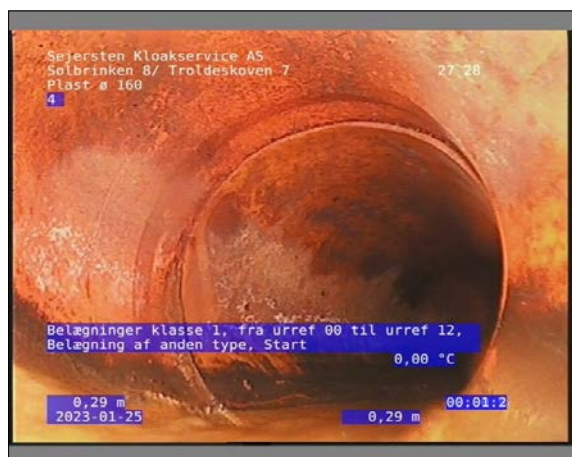
Foto: 20_1_6_25012023_123243_1.JPG 0,29m, Belægninger klasse 1, fra urref 00 til urref 12, Belægning af anden type, Start
