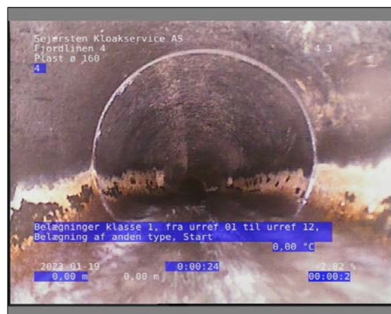
Foto: 1_1_2_19012023_141738_1.JPG 0m, Belægninger klasse 1, fra urref 01 til urref 12, Belægning af anden type, Start
