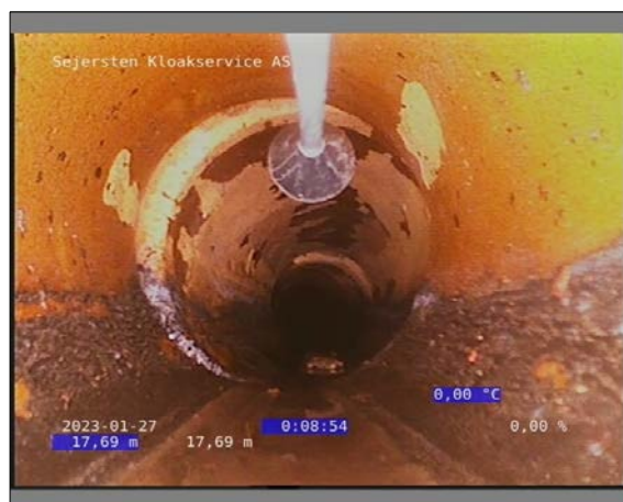
Foto: 28_1_23_27012023_103746_1.JPG 17,69m, FS3, Forskudt samling
