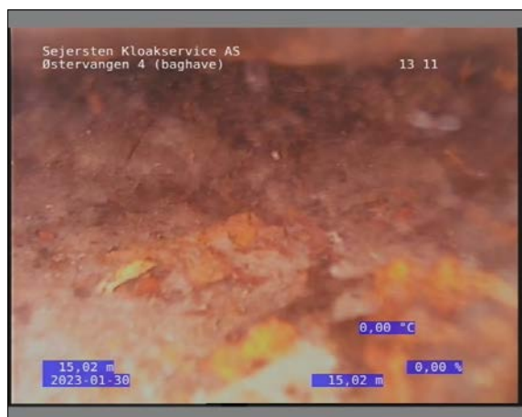
Foto: 31_1_44_30012023_144547_1.JPG 15,02m, Aflejring klasse 3, fra urref 00 til urref 12, Sand/Grus, Start
