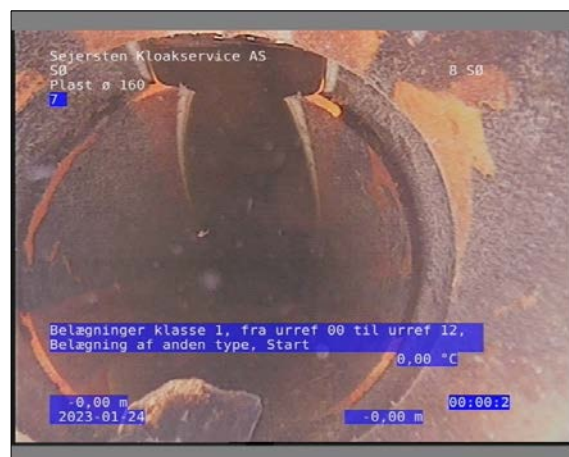
Foto: 16_1_5_24012023_134903_1.JPG 0,02m, Belægninger klasse 1, fra urref 00 til urref 12, Belægning af anden type, Start
