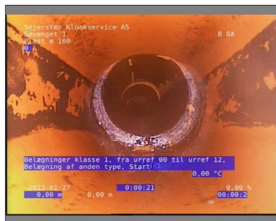
Foto: 27_1_3_27012023_100843_1.JPG 0m, Belægninger klasse 1, fra urref 00 til urref 12, Belægning af anden type, Start
