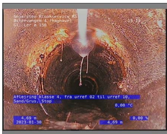
Foto: 31_1_20_30012023_142520_1.JPG 4,69m, Aflejring klasse 4, fra urref 02 til urref 10, Sand/Grus, Stop
