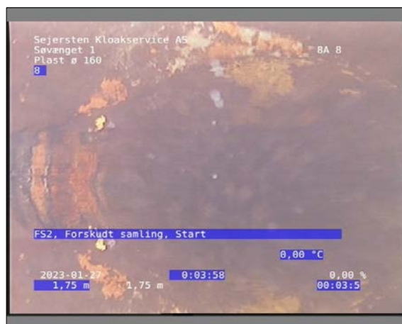
Foto: 29_1_8_27012023_113428_1.JPG 1,75m, FS2, Forskudt samling, Start
