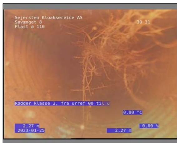
Foto: 17_1_9_25012023_090348_1.JPG 2,27m, Rødder klasse 3, fra urref 00 til urref 12, Fine rødder, Start
