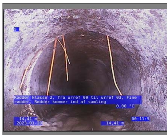
Foto: 3_1_21_20012023_095322_1.JPG 14,41m, Rødder klasse 2, fra urref 09 til urref 03, Fine rødder / Rødder kommer ind af samling
