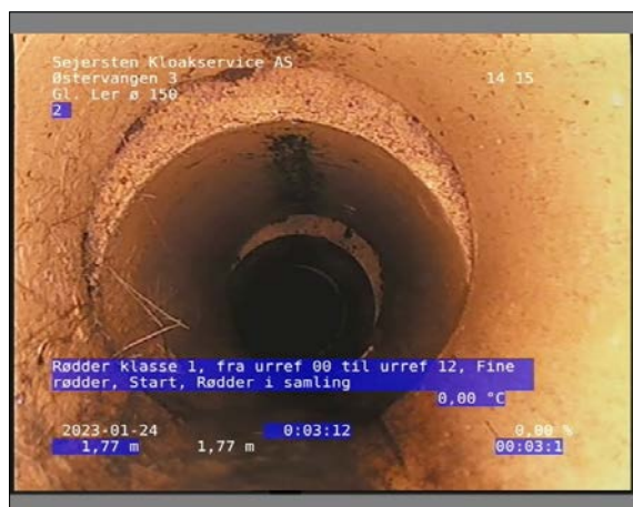
Foto: 13_1_10_24012023_095908_1.JPG 1,77m, Rødder klasse 1, fra urref 00 til urref 12, Fine rødder, Start / Rødder i samling
