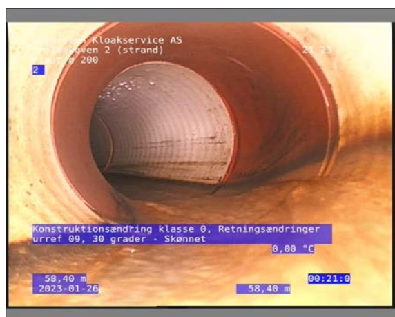
Foto: 22_1_28_26012023_083206_1.JPG 58,4m, Konstruktionsændring klasse 0, Retningsændringer urref 09 / 30 grader - Skønnet
