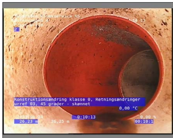
Foto: 14_1_22_24012023_114848_1.JPG 26,25m, Konstruktionsændring klasse 0, Retningsændringer urref 03 / 45 grader - skønnet
