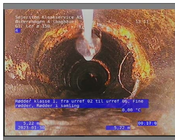
Foto: 31_1_26_30012023_142822_1.JPG 5,22m, Rødder klasse 1, fra urref 02 til urref 06, Fine rødder / Rødder i samling
