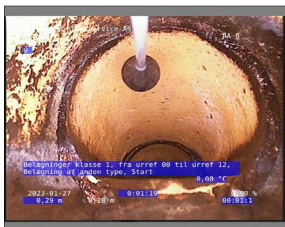
Foto: 29_1_5_27012023_113054_1.JPG 0,29m, Belægninger klasse 1, fra urref 00 til urref 12, Belægning af anden type, Start
