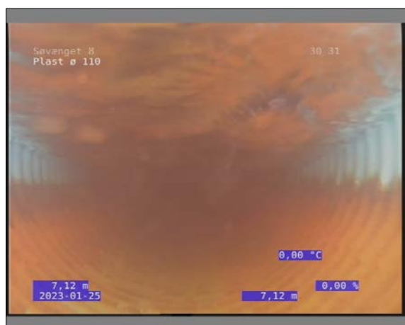
Foto: 17_1_11_25012023_090657_1.JPG 7,11m, Rødder klasse 3, fra urref 00 til urref 12, Fine rødder, Stop
