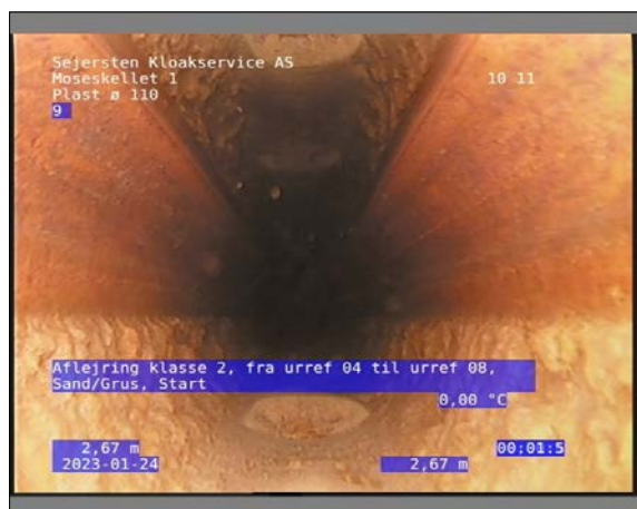
Foto: 12_1_6_24012023_083310_1.JPG 2,67m, Aflejring klasse 2, fra urref 04 til urref 08, Sand/Grus, Start
