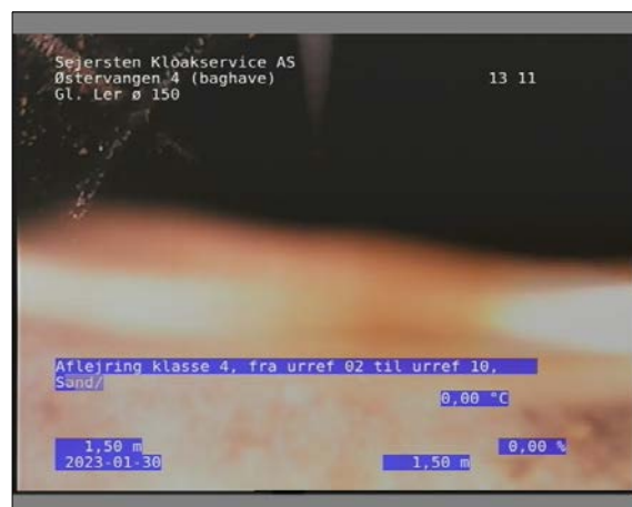
Foto: 31_1_12_30012023_141309_1.JPG 1,5m, Aflejring klasse 4, fra urref 02 til urref 10, Sand/Grus, Start / 50% skønnet
