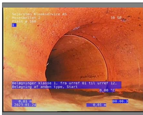
Foto: 11_1_3_24012023_075917_1.JPG 0,01m, Belægninger klasse 1, fra urref 01 til urref 12, Belægning af anden type, Start
