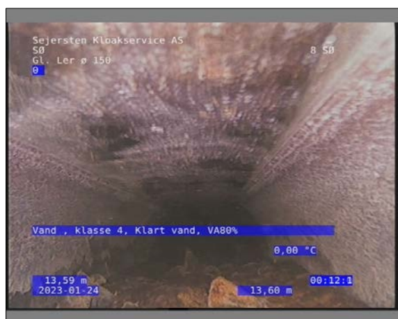
Foto: 16_1_14_24012023_141230_1.JPG 13,6m, Vand , klasse 4 / Klart vand, VA80%
