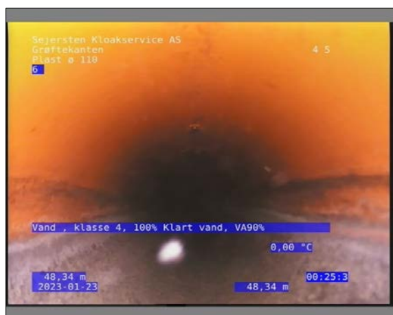
Foto: 6_1_22_23012023_105109_1.JPG 48,34m, Vand, klasse 4 / 100% Klart vand, VA90%
