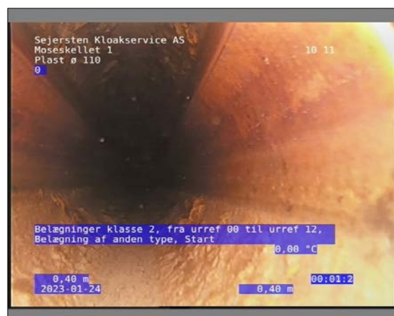
Foto: 12_1_5_24012023_083206_1.JPG 0,4m, Belægninger klasse 2, fra urref 00 til urref 12, Belægning af anden type, Start
