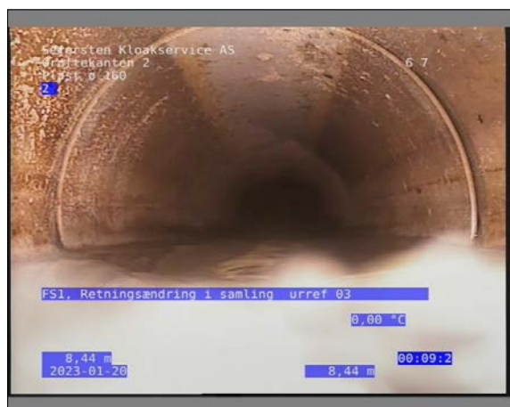
Foto: 4_1_17_20012023_103437_1.JPG 8,44m, FS1, Retningsændring i samling urref 03
