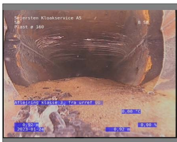
Foto: 16_1_6_24012023_135032_1.JPG 0,92m, Aflejrings klasse 3, fra urref 00 til urref 12, Sand/Grus, Start
