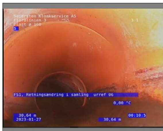
Foto: 25_1_15_27012023_085731_1.JPG 30,64m, FS1, Retningsændring i samling urref 06
