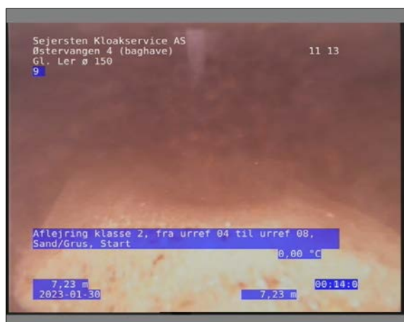
Foto: 30_1_20_30012023_131316_1.JPG 7,23m, Aflejring klasse 2, fra urref 04 til urref 08, Sand/Grus, Start
