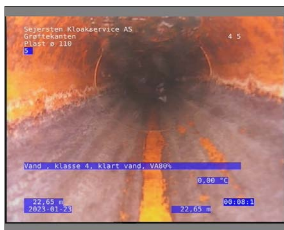
Foto: 6_1_10_23012023_103023_1.JPG 22,65m, Vand , klasse 4 / klart vand, VA80%
