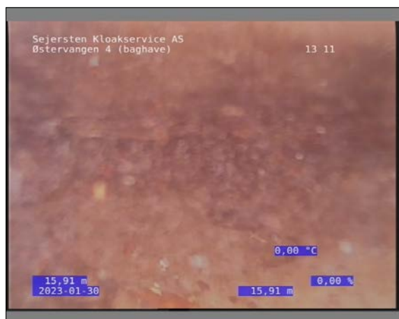
Foto: 31_1_49_30012023_145447_1.JPG 15,91m, Rødder klasse 3, fra urref 00 til urref 12, Rodklump, Stop
