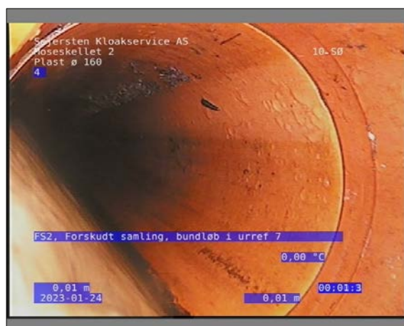
Foto: 11_1_5_24012023_080110_1.JPG 0,01m, FS2, Forskudt samling / bundløb i urref 7
