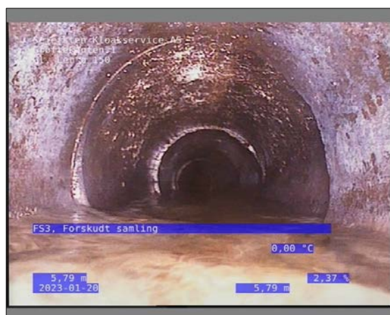
Foto: 3_1_12_20012023_094223_1.JPG 5,79m, FS3, Forskudt samling
