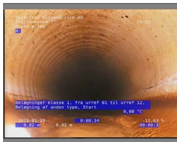
Foto: 9_1_3_23012023_140429_1.JPG 0,02m, Belægninger klasse 1, fra urref 01 til urref 12, Belægning af anden type, Start
