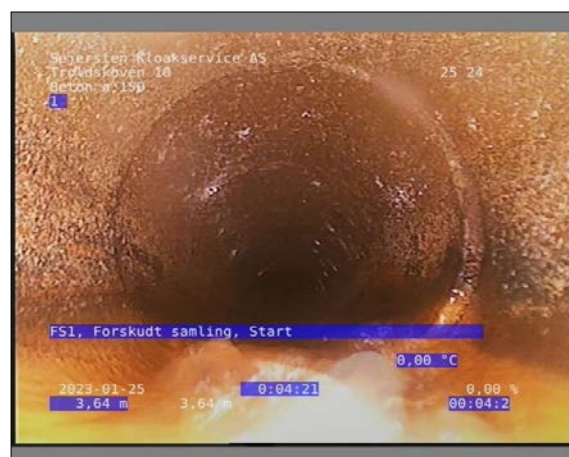
Foto: 21_1_9_25012023_133400_1.JPG 3,64m, FS1, Forskudt samling, Start
