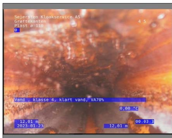
Foto: 6_1_7_23012023_102415_1.JPG 12,01m, Vand , klasse 4 / klart vand, VA70%
