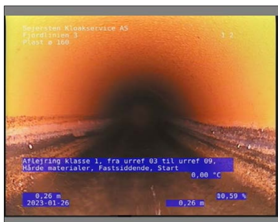
Foto: 24_1_4_26012023_100939_1.JPG 0,26m, Aflejring klasse 1, fra urref 03 til urref 09, Hårde materialer, Fastsiddende, Start
