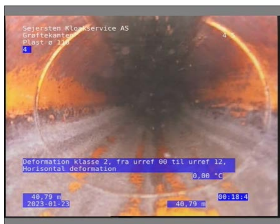
Foto: 6_1_18_23012023_104247_1.JPG 40,79m, Deformation klasse 2, fra urref 00 til urref 12, Horizontal deformation
