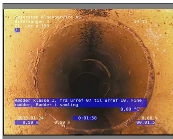
Foto: 13_1_7_24012023_095657_1.JPG 0,59m, Rødder klasse 1, fra urref 07 til urref 10, Fine rødder / Rødder i samling
