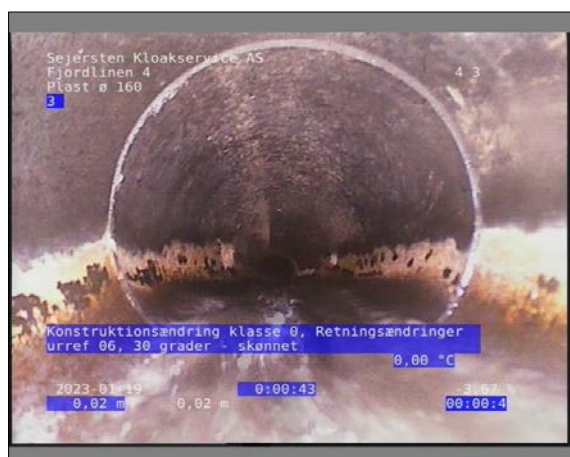
Foto: 1_1_3_19012023_141819_1.JPG 0,02m, Konstruktionsændring klasse 0, Retningsændringer urref 06 / 30 grader - skønnet
