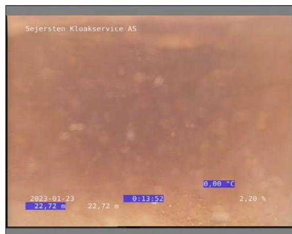
Foto: 8_1_16_23012023_133540_1.JPG 22,74m, Aflejring klasse 2, fra urref 05 til urref 07, Sand/Grus
