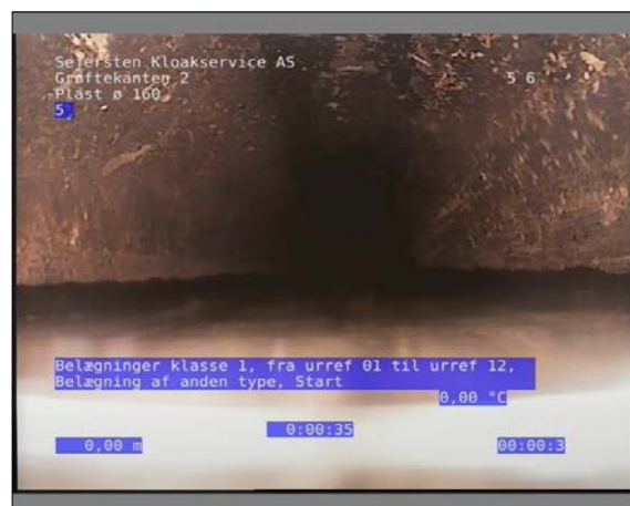
Foto: 2_1_2_19012023_145905_1.JPG Om, Belægninger klasse 1, fra urref 01 til urref 12, Belægning af anden type, Start
