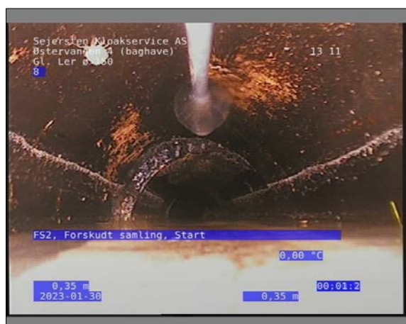
Foto: 31_1_4_30012023_140058_1.JPG 0,35m, FS2, Forskudt samling, Start
