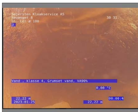
Foto: 17_1_21_25012023_092109_1.JPG 22,22m, Vand, klasse 4 / Grumset vand, VA90%
