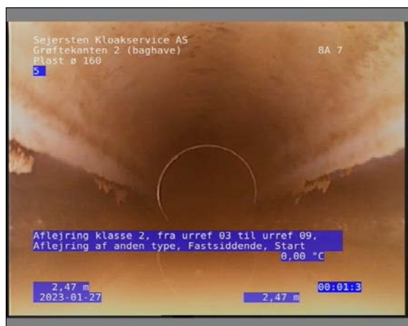
Foto: 26_1_7_27012023_092609_1.JPG 2,47m, Aflejring klasse 2, fra urref 03 til urref 09, Aflejring af anden type, Fastsiddende, Start
