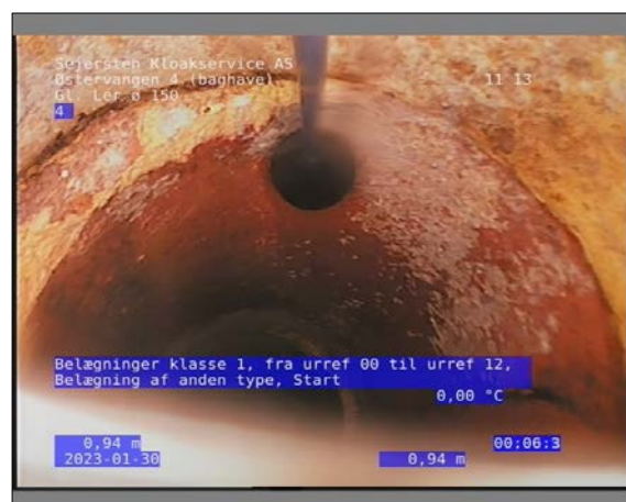
Foto: 30_1_5_30012023_125502_1.JPG 0,94m, Belægninger klasse 1, fra urref 00 til urref 12, Belægning af anden type, Start
