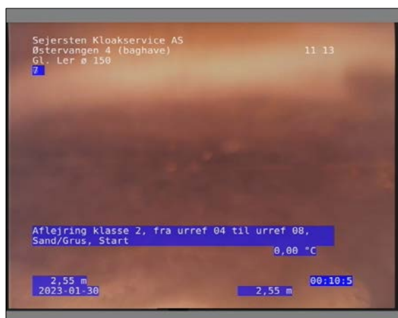
Foto: 30_1_15_30012023_130758_1.JPG 2,55m, Aflejring klasse 2, fra urref 04 til urref 08, Sand/Grus, Start
