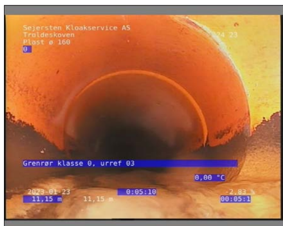
Foto: 8_1_10_23012023_132409_1.JPG 11,15m, Grenrør klasse 0, urref 03
