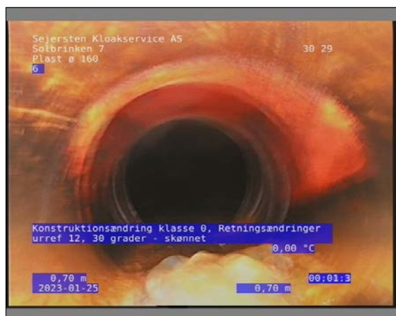
Foto: 18_1_6_25012023_103912_1.JPG 0,7m, Konstruktionsændring klasse 0, Retningsændringer urref 12 / 30 grader - skønnet
