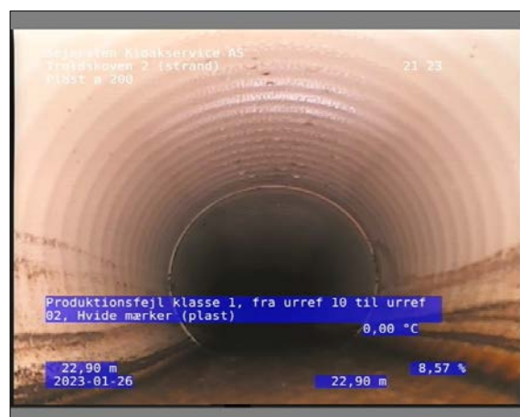
Foto: 22_1_11_26012023_081610_1.JPG 22,9m, Produktionsfejl klasse 1, fra urref 10 til urref 02, Hvide mærker (plast)
