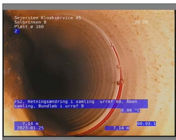
Foto: 19_1_8_25012023_110610_1.JPG 7,14m, FS2, Retningsændring i samling urref 09, Åben samling / Bundløb i urref 9
