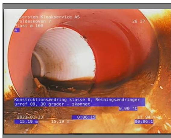
Foto: 10_1_11_23012023_145246_1.JPG 15,19m, Konstruktionsændring klasse 0, Retningsændringer urref 09 / 30 grader - skønnet
