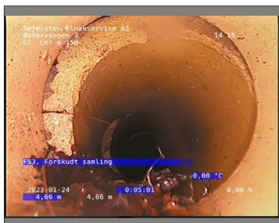
Foto: 13_1_13_24012023_100131_1.JPG 4,66m, FS3, Forskudt samling
