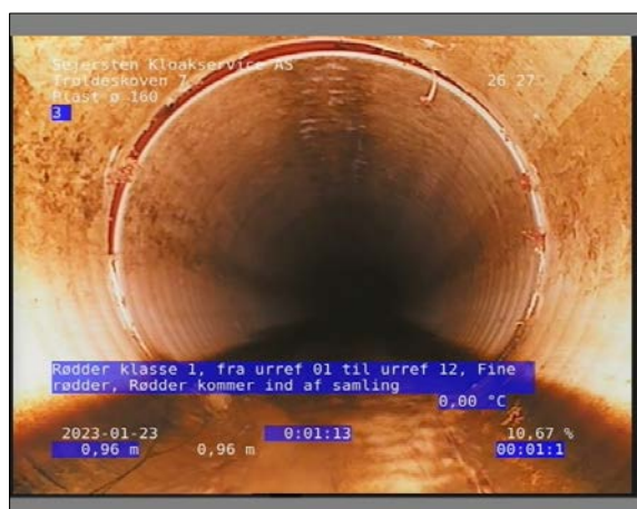
Foto: 10_1_4_23012023_144453_1.JPG 0,96m, Rødder klasse 1, fra urref 01 til urref 12, Fine rødder / Rødder kommer ind af samling
