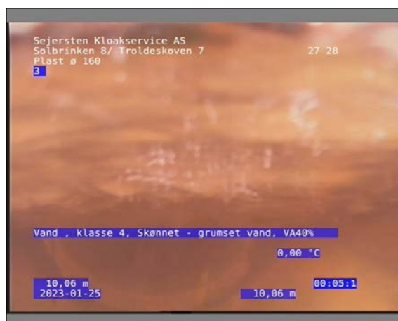
Foto: 20_1_10_25012023_123843_1.JPG 10,05m, Vand, klasse 4 / Skønnet - grumset vand, VA40%
