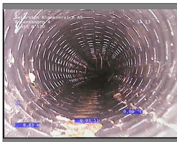
Foto: 14_1_7_24012023_113820_1.JPG 8,85m, Deformation klasse 3, fra urref 00 til urref 12, Horizontal deformation, Stop
