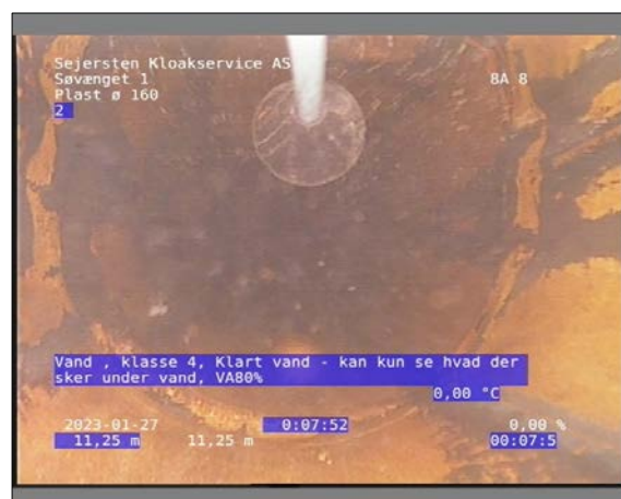
Foto: 29_1_15_27012023_114120_1.JPG 11,25m, Vand, klasse 4 / Klart vand - kan kun se hvad der sker under vand, VA80%
