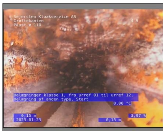
Foto: 6_1_5_23012023_102128_1.JPG 0,15m, Belægninger klasse 1, fra urref 01 til urref 12, Belægning af anden type, Start
