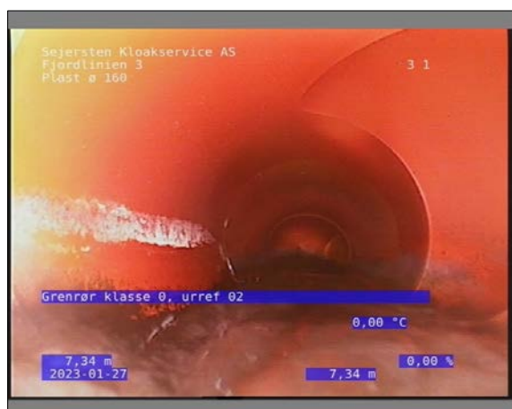
Foto: 25_1_9_27012023_084821_1.JPG 7,34m, Grenrør klasse 0, urref 02
