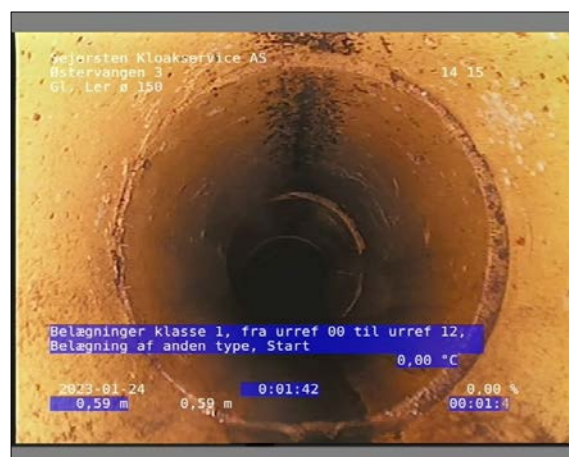
Foto: 13_1_5_24012023_095554_1.JPG 0,59m, Belægninger klasse 1, fra urref 00 til urref 12, Belægning af anden type, Start
