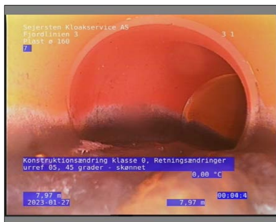
Foto: 25_1_11_27012023_084941_1.JPG 7,96m, Konstruktionsændring klasse 0, Retningsændringer urref 05 / 45 grader - skønnet
