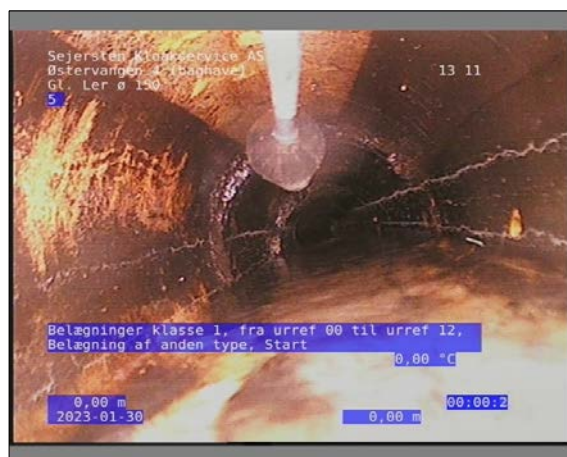
Foto: 31_1_3_30012023_135943_1.JPG 0m, Belægninger klasse 1, fra urref 00 til urref 12, Belægning af anden type, Start
