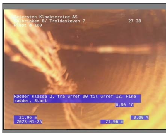
Foto: 20_1_19_25012023_124829_1.JPG 21,96m, Rødder klasse 2, fra urref 00 til urref 12, Fine rødder, Start
