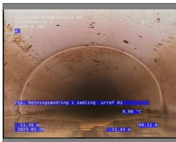
Foto: 4_1_18_20012023_103645_1.JPG 11,45m, FS1, Retningsændring i samling urref 03
