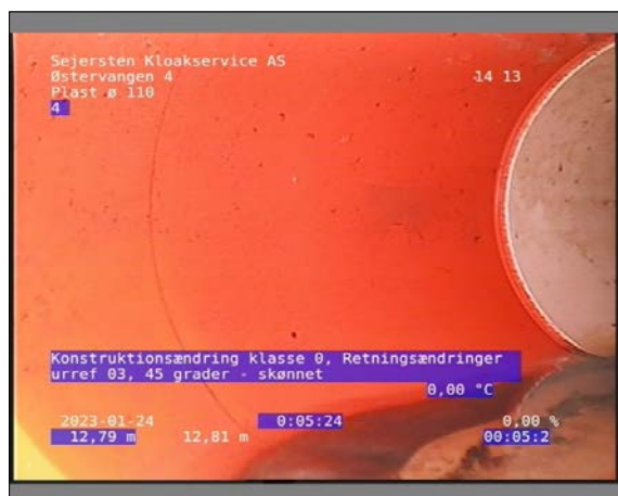
Foto: 14_1_11_24012023_114122_1.JPG 12,81m, Konstruktionsændring klasse 0, Retningsændringer urref 03 / 45 grader - skønnet
