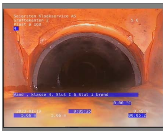
Foto: 2_1_12_19012023_150658_1.JPG 5,65m, Vand, klasse 4 / Slut I 6 Slut i brønd
