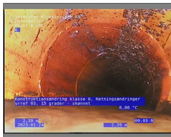
Foto: 11_1_7_24012023_080317_1.JPG 2,39m, Konstruktionsændring klasse 0, Retningsændringer urref 03, 15 grader - skønnet
