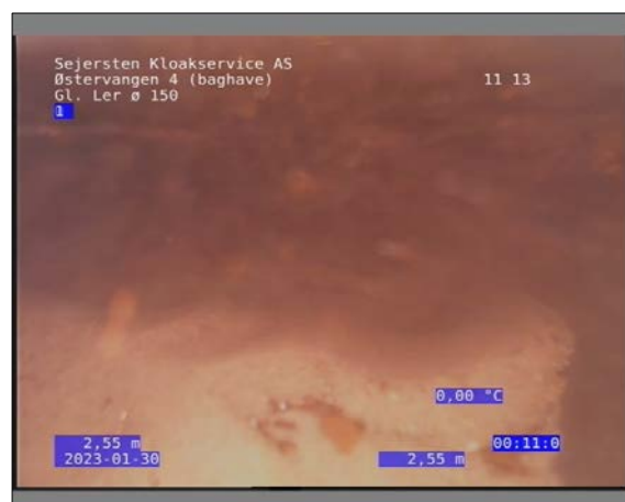
Foto: 30_1_15_30012023_130802_2.JPG 2,55m, Aflejring klasse 2, fra urref 04 til urref 08, Sand/Grus, Start
