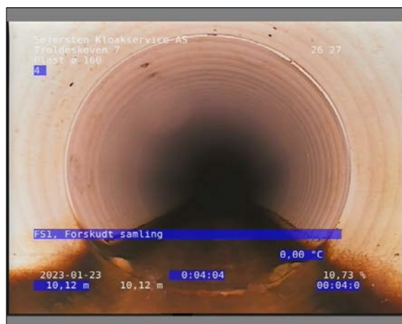
Foto: 10_1_7_23012023_144826_1.JPG 10,12m, FS1, Forskudt samling
