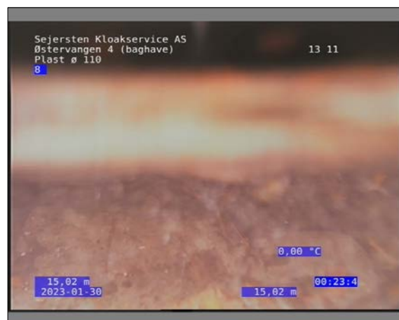
Foto: 31_1_44_30012023_144554_2.JPG 15,02m, Aflejring klasse 3, fra urref 00 til urref 12, Sand/Grus, Start
