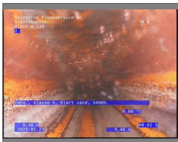
Foto: 6_1_6_23012023_102327_1.JPG 9,46m, Vand , klasse 4 / Klart vand, VA90%
