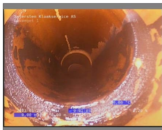
Foto: 27_1_5_27012023_101024_1.JPG 0,3m, FS3, Forskudt samling
