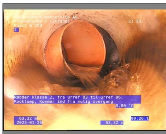
Foto: 22_1_34_26012023_084009_1.JPG 63,32m, Rødder klasse 2, fra urref 03 til urref 06, Rodklump / Kommer ind fra mulig overgang
