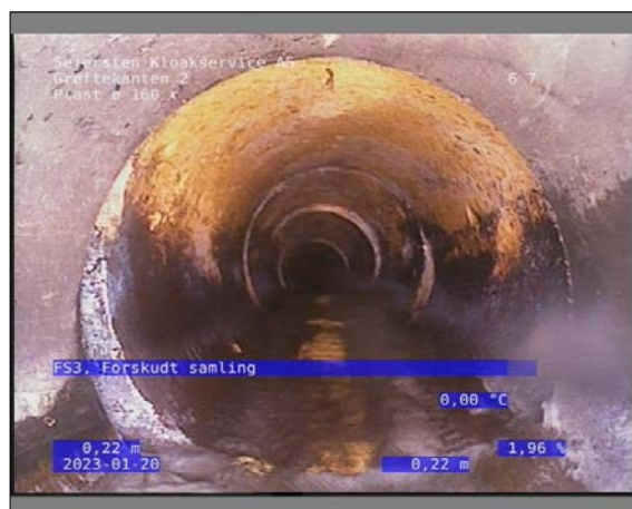
Foto: 4_1_2_20012023_102025_1.JPG 0,22m, FS3, Forskudt samling
