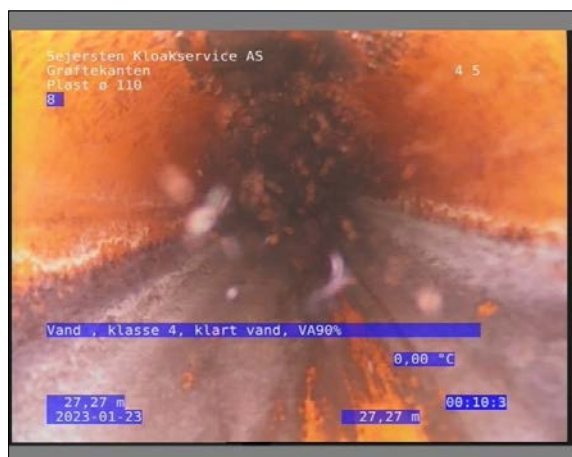
Foto: 6_1_11_23012023_103300_1.JPG 27,27m, Vand , klasse 4 / klart vand, VA90%
