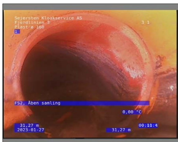
Foto: 25_1_16_27012023_085827_1.JPG 31,27m, FS2, Åben samling
