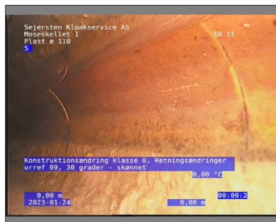
Foto: 12_1_3_24012023_083005_1.JPG 0,1m, Konstruktionsændring klasse 0, Retningsændringer urref 09 / 30 grader - skønnet
