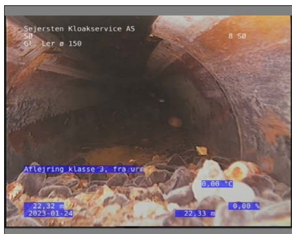
Foto: 16_1_17_24012023_142036_1.JPG 22,33m, Aflejring klasse 3, fra urref 00 til urref 12, Sand/Grus, Stop
