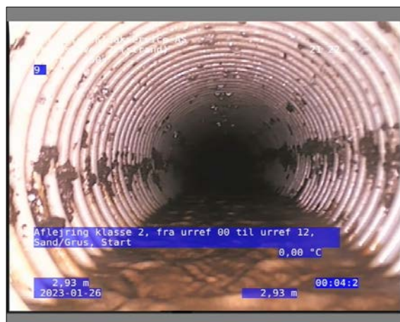
Foto: 23_1_13_26012023_094457_1.JPG 2,93m, Aflejring klasse 2, fra urref 00 til urref 12, Sand/Grus, Start
