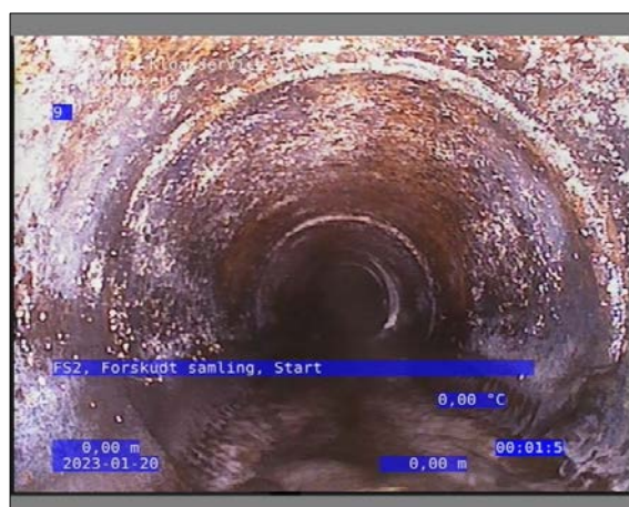
Foto: 3_1_4_20012023_093648_1.JPG 0,15m, FS2, Forskudt samling, Start
