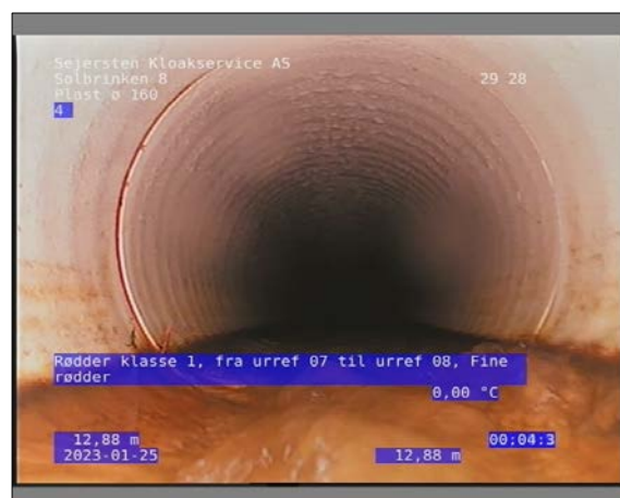
Foto: 19_1_9_25012023_110753_1.JPG 12,88m, Rødder klasse 1, fra urref 07 til urref 08, Fine rødder
