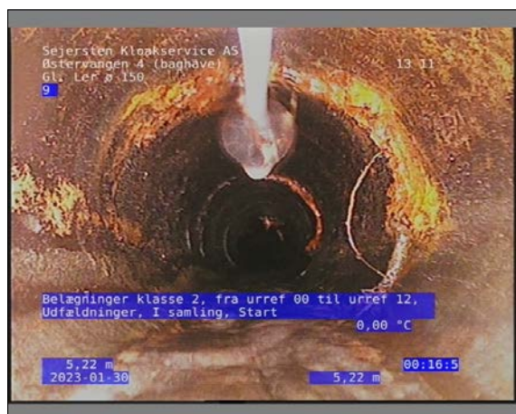
Foto: 31_1_25_30012023_142753_1.JPG 5,22m, Belægninger klasse 2, fra urref 00 til urref 12, Udfældninger, I samling, Start
