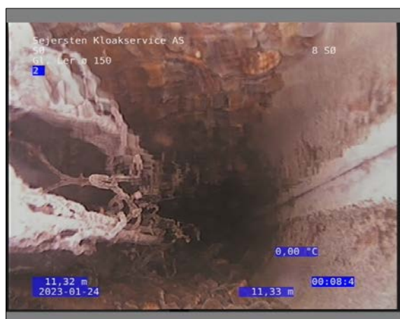
Foto: 16_1_11_24012023_140750_1.JPG 11,33m, Rødder klasse 3, fra urref 00 til urref 12, Pælerod, Start / Pælerod løber i ledning
