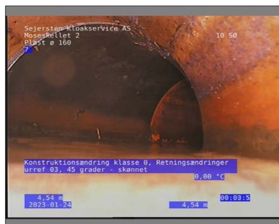
Foto: 11_1_9_24012023_080437_1.JPG 4,54m, Konstruktionsændring klasse 0, Retningsændringer urref 03 / 45 grader - skønnet
