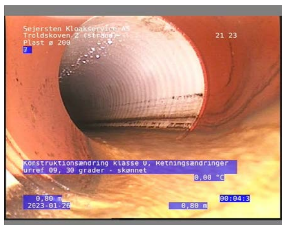
Foto: 22_1_5_26012023_080812_1.JPG 0,8m, Konstruktionsændring klasse 0, Retningsændringer urref 09 / 30 grader - skønnet
