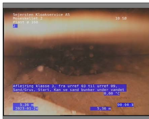
Foto: 11_1_11_24012023_080625_1.JPG 5,36m, Aflejring klasse 3, fra urref 03 til urref 09, Sand/Grus, Start / Kan se sand bunker under vandet
