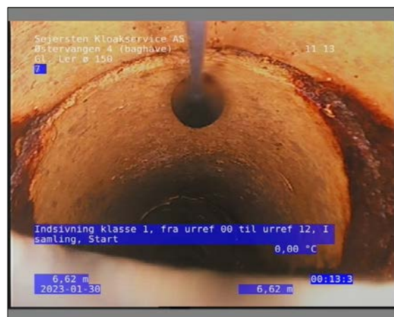
Foto: 30_1_18_30012023_131206_1.JPG 6,62m, Indsivning klasse 1, fra urref 00 til urref 12, I samling, Start
