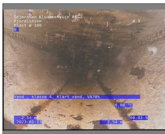
Foto: 7_1_9_23012023_113728_1.JPG 2,54m, Vand , klasse 4 / Klart vand, VA70%
