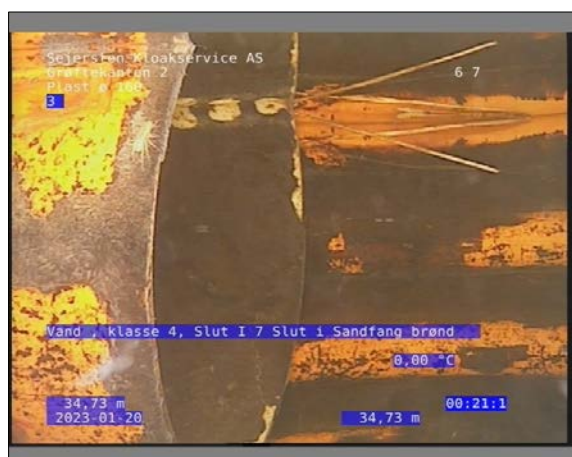
Foto: 4_1_39_20012023_105129_1.JPG 34,73m, Vand , klasse 4 / Slut I 7 Slut i Sandfang brønd
