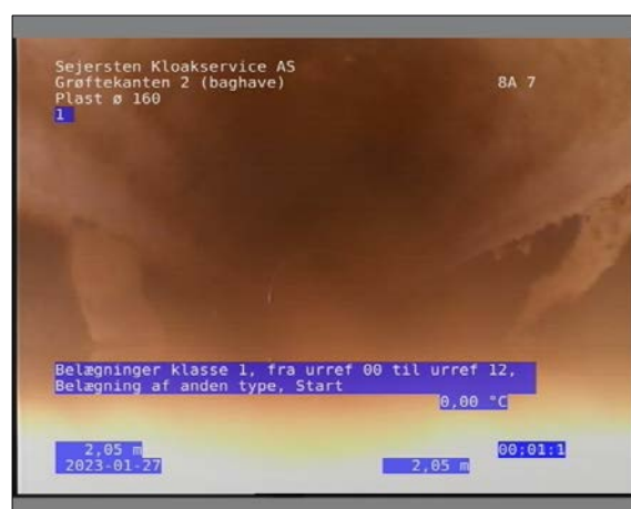
Foto: 26_1_6_27012023_092525_1.JPG 2,05m, Belægninger klasse 1, fra urref 00 til urref 12, Belægning af anden type, Start
