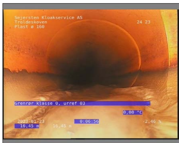
Foto: 8_1_13_23012023_132650_1.JPG 16,45m, Grenrør klasse 0, urref 03
