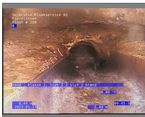
Foto: 7_1_15_23012023_114200_1.JPG 6,44m, Vand, klasse 2 / Slut i 3 Slut i brønd
