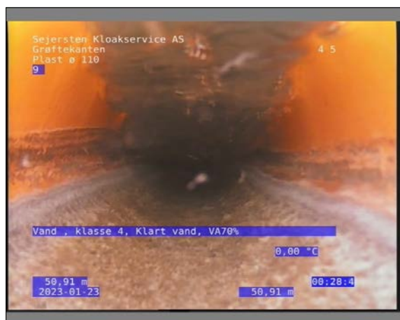
Foto: 6_1_24_23012023_105452_1.JPG 50,91m, Vand , klasse 4 / Klart vand, VA70%
