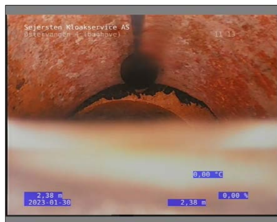
Foto: 30_1_14_30012023_130720_1.JPG 2,38m, FS3, Forskudt samling, Start
