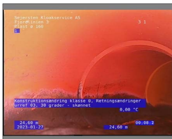
Foto: 25_1_13_27012023_085412_1.JPG 24,6m, Konstruktionsændring klasse 0, Retningsændringer urref 03 / 30 grader - skønnet
