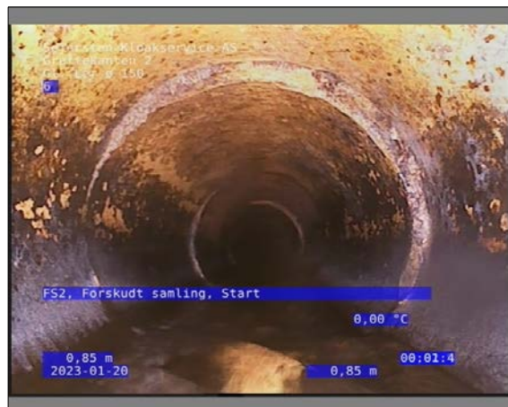
Foto: 4_1_6_20012023_102308_1.JPG 0,85m, FS2, Forskudt samling, Start
