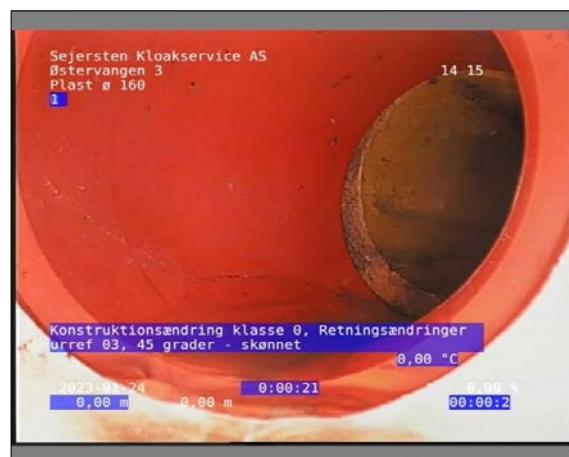
Foto: 13_1_3_24012023_095338_1.JPG 0,1m, Konstruktionsændring klasse 0, Retningsændringer urref 03 / 45 grader - skønnet
