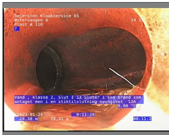
Foto: 14_1_24_24012023_115220_1.JPG 28,41m, Vand , klasse 2 / Slut I 13 Sluter i kke brønd som antaget men i en stiktilslutning navngivet 13A
