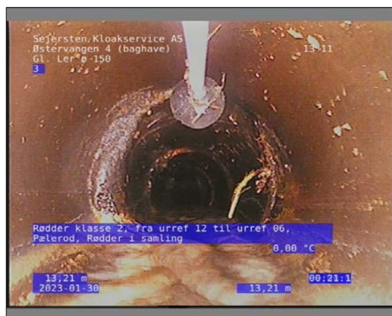
Foto: 31_1_36_30012023_143559_1.JPG 13,2m, Rødder klasse 2, fra urref 12 til urref 06, Pælerod / Rødder i samling
