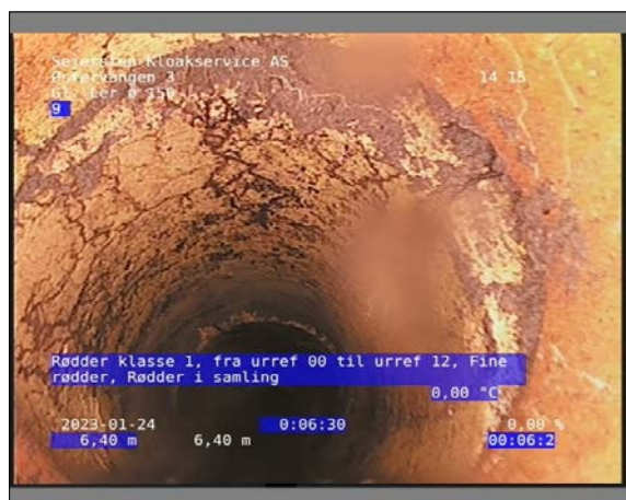
Foto: 13_1_15_24012023_100424_1.JPG 6,4m, Rødder klasse 1, fra urref 00 til urref 12, Fine rødder / Rødder i samling
