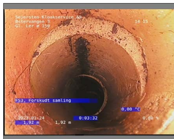
Foto: 13_1_11_24012023_095937_1.JPG 1,92m, FS3, Forskudt samling
