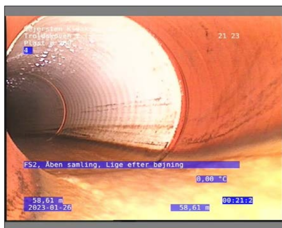
Foto: 22_1_29_26012023_083249_1.JPG 58,61m, FS2, Åben samling / Lige efter bøjning
