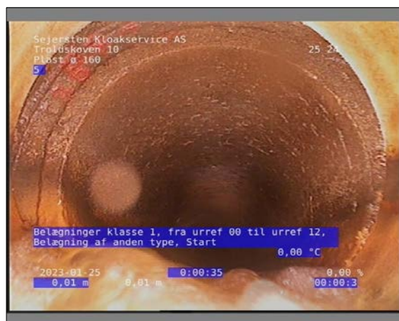
Foto: 21_1_3_25012023_132645_1.JPG 0,01m, Belægninger klasse 1, fra urref 00 til urref 12, Belægning af anden type, Start
