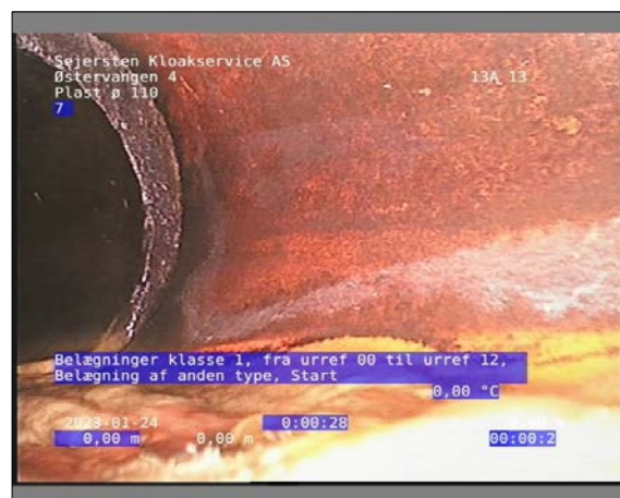
Foto: 15_1_3_24012023_120642_1.JPG 0m, Belægninger klasse 1, fra urref 00 til urref 12, Belægning af anden type, Start
