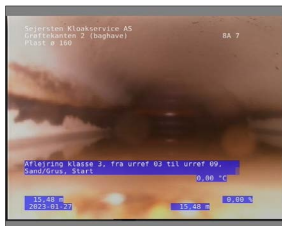
Foto: 26_1_16_27012023_093529_1.JPG 15,48m, Aflejring klasse 3, fra urref 03 til urref 09, Sand/Grus, Start
