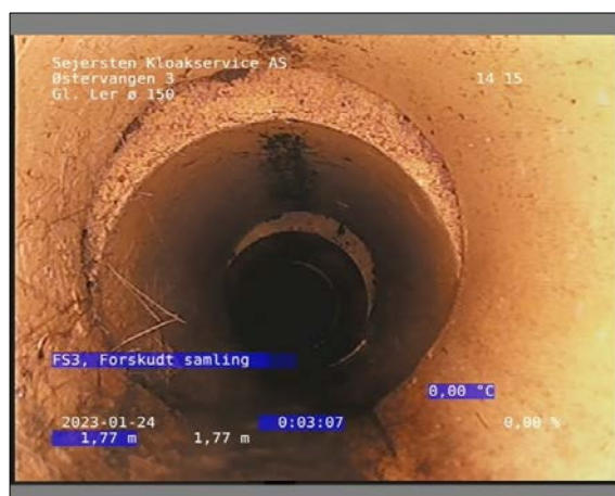
Foto: 13_1_9_24012023_095838_1.JPG 1,77m, FS3, Forskudt samling
