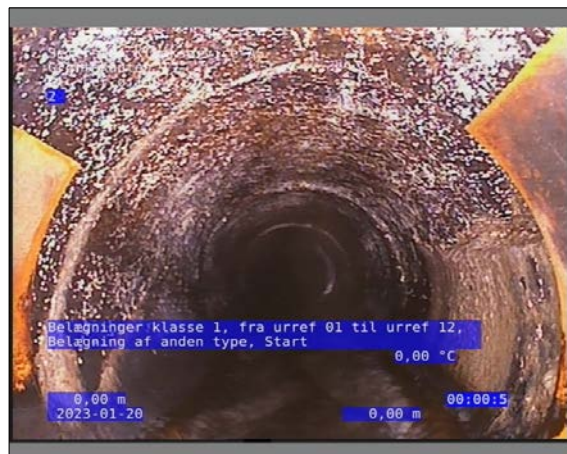
Foto: 3_1_2_20012023_093417_1.JPG 0m, Belægninger klasse 1, fra urref 01 til urref 12, Belægning af anden type, Start
