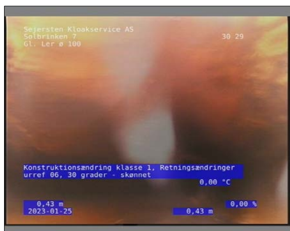
Foto: 18_1_4_25012023_103758_1.JPG 0,43m, Konstruktionsændring klasse 1, Retningsændringer urref 06 / 30 grader - skønnet
