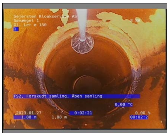
Foto: 28_1_6_27012023_102729_1.JPG 1,88m, FS2, Forskudt samling, Åben samling
