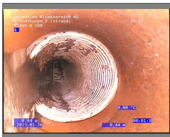
Foto: 23_1_5_26012023_093855_2.JPG 0,44m, Grenrør klasse 0, urref 09 / Drænrør ø150 - skønnet
