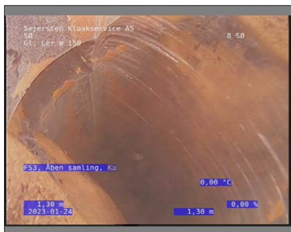
Foto: 16_1_8_24012023_135257_1.JPG 1,3m, FS3, Åben samling / Kamera er under vand
