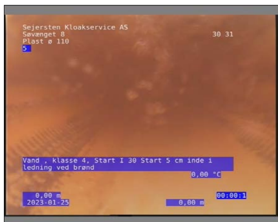
Foto: 17_1_1_25012023_082142_1.JPG 0m, Vand, klasse 4 / Start I 30 Start 5 cm inde i ledning ved brønd
