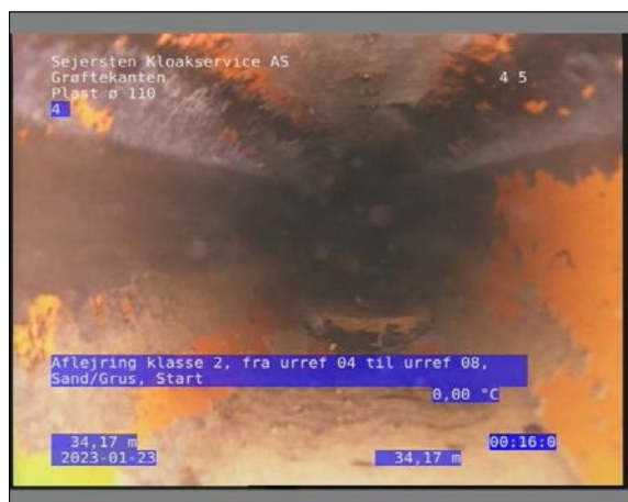
Foto: 6_1_15_23012023_103937_1.JPG 34,17m, Aflejring klasse 2, fra urref 04 til urref 08, Sand/Grus, Start
