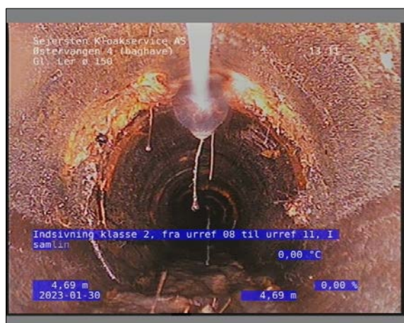
Foto: 31_1_22_30012023_142623_1.JPG 4,69m, Indsivning klasse 2, fra urref 08 til urref 11, I samling
