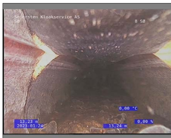
Foto: 16_1_13_24012023_141152_1.JPG 13,24m, FS3, Forskudt samling, Åben samling / Skønnet kamera under vand
