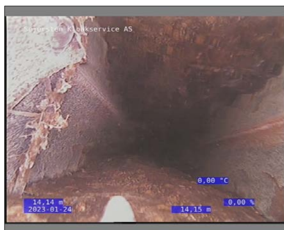
Foto: 16_1_15_24012023_141330_1.JPG 14,15m, FS3, Forskudt samling, Åben samling / Skønnet - kamera under vand
