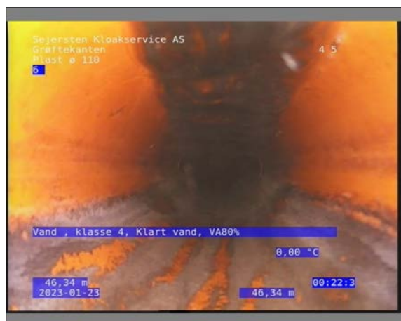
Foto: 6_1_20_23012023_104725_1.JPG 46,34m, Vand, klasse 4 / Klart vand, VA80%
