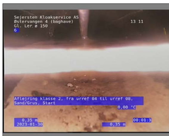
Foto: 31_1_5_30012023_140127_1.JPG 0,35m, Aflejring klasse 2, fra urref 04 til urref 08, Sand/Grus, Start
