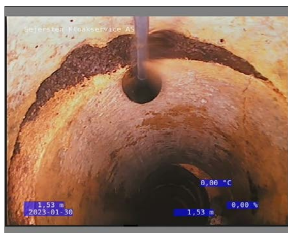
Foto: 30_1_9_30012023_125657_1.JPG 1,53m, FS3, Forskudt samling
