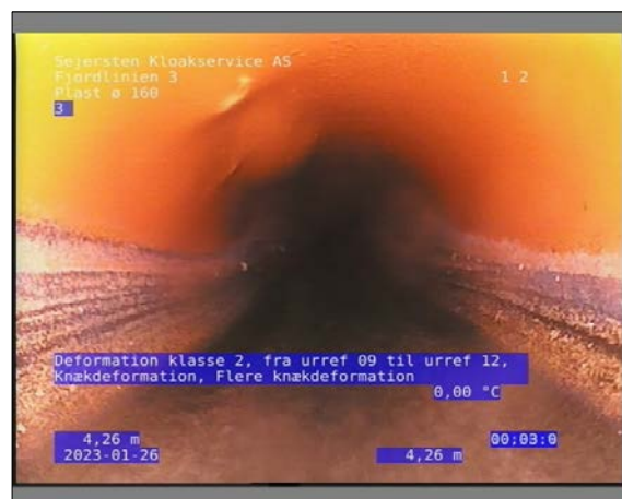
Foto: 24_1_7_26012023_101403_1.JPG 4,26m, Deformation klasse 2, fra urref 09 til urref 12, Knækdeformation / Flere knækdeformation
