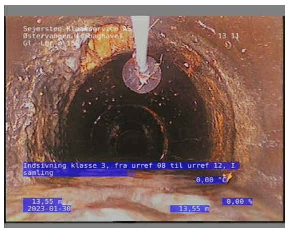
Foto: 31_1_37_30012023_143653_1.JPG 13,55m, Indsivning klasse 3, fra urref 08 til urref 12, I samling
