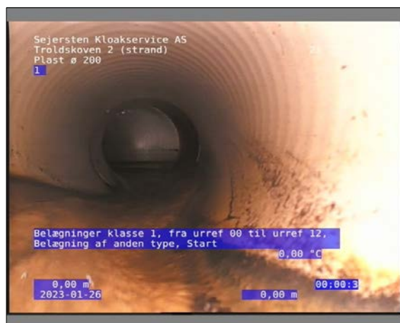
Foto: 22_1_3_26012023_080255_1.JPG 0m, Belægninger klasse 1, fra urref 00 til urref 12, Belægning af anden type, Start
