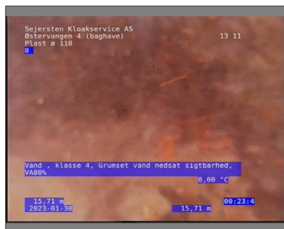
Foto: 31_1_46_30012023_144934_1.JPG 15,71m, Vand , klasse 4 / Grumset vand nedsat sigtbarhed, VA80%
