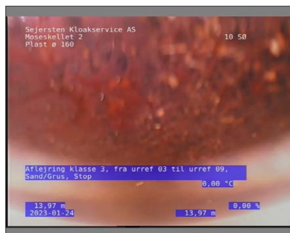
Foto: 11_1_13_24012023_080914_1.JPG 13,97m, Aflejring klasse 3, fra urref 03 til urref 09, Sand/Grus, Stop
