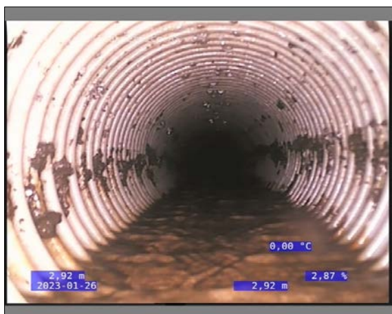
Foto: 23_1_12_26012023_094421_1.JPG 2,92m, Aflejring klasse 3, fra urref 00 til urref 12, Sand/Grus, Stop
