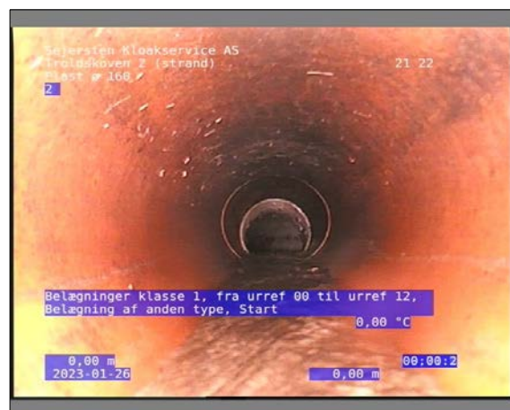
Foto: 23_1_3_26012023_093620_1.JPG 0m, Belægninger klasse 1, fra urref 00 til urref 12, Belægning af anden type, Start
