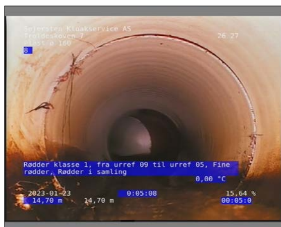
Foto: 10_1_9_23012023_145022_1.JPG 14,7m, Rødder klasse 1, fra urref 09 til urref 05, Fine rødder / Rødder i samling
