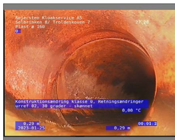
Foto: 20_1_5_25012023_123229_1.JPG 0,29m, Konstruktionsændring klasse 0, Retningsændringer urref 02 / 30 grader - skønnet
