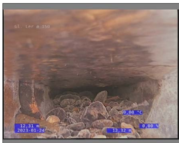
Foto: 16_1_12_24012023_140917_1.JPG 12,32m, FS3, Forskudt samling, Åben samling / Skønnet kamera er under vand
