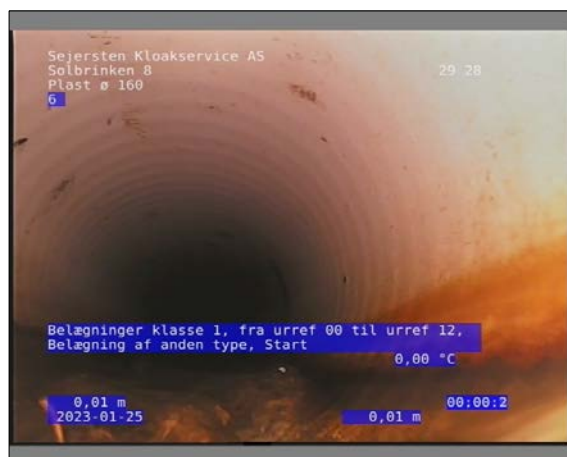
Foto: 19_1_3_25012023_110046_1.JPG 0,01m, Belægninger klasse 1, fra urref 00 til urref 12, Belægning af anden type, Start
