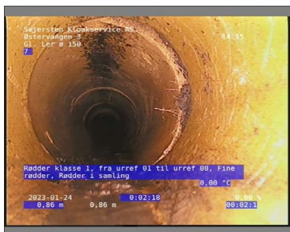
Foto: 13_1_8_24012023_095741_1.JPG 0,86m, Rødder klasse 1, fra urref 01 til urref 08, Fine rødder / Rødder i samling
