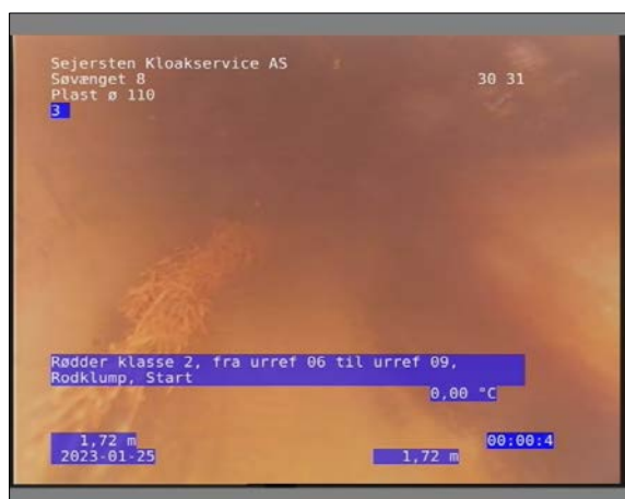
Foto: 17_1_4_25012023_085742_1.JPG 1,72m, Rødder klasse 2, fra urref 03 til urref 06, Rodklump, Start / Fejl i skærmtekest i urref
