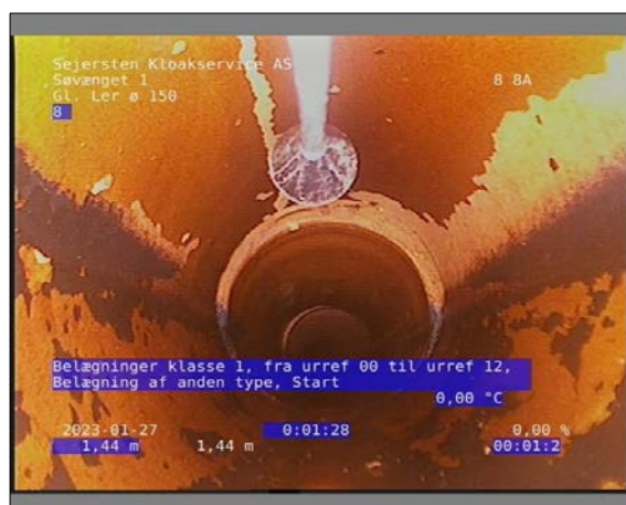
Foto: 28_1_5_27012023_102622_1.JPG 1,44m, Belægninger klasse 1, fra urref 00 til urref 12, Belægning af anden type, Start
